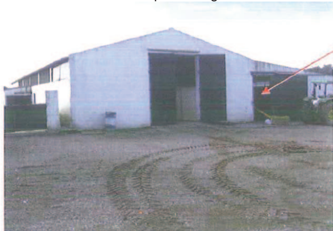
Nave de almacenamiento del pienso
