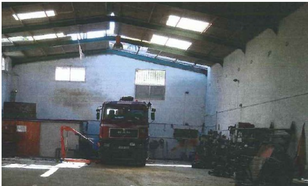
Imagen 2. Interior de la nave
