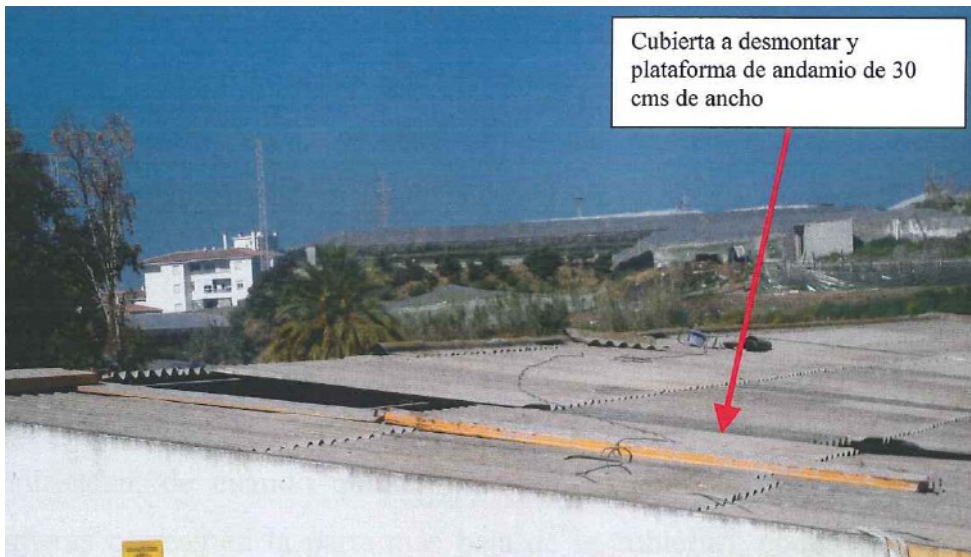
Imagen 1. Cubierta a desmontar
